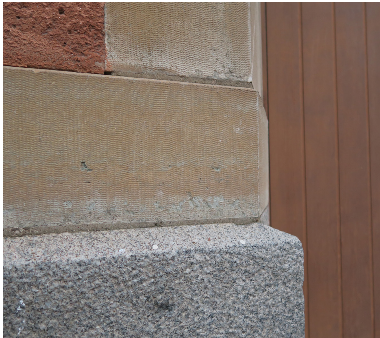
Materialmedvetenheten är slående vid en detaljgranskning av byggnaden. Bilden överst och bilden nere t.v. ses den gråa kalkstenens tandsnittshuggning. Nedre bilden t.h. illustrerar den gulaktiga kalkstenen med finbearbetad yta samt den krysshamrade graniten nederst i bild. Bild 11- 13
